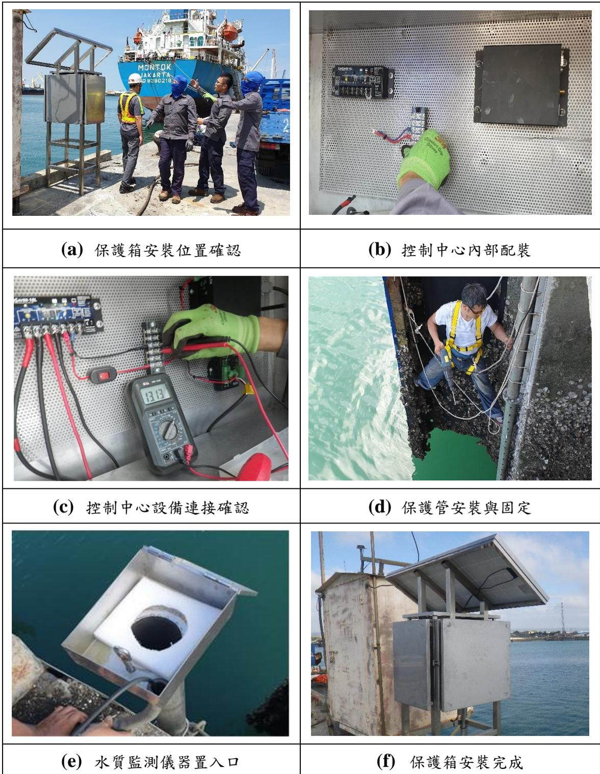
圖 3.10 水質監測系統安裝作業情況 (108 年 5 月 30 日)
