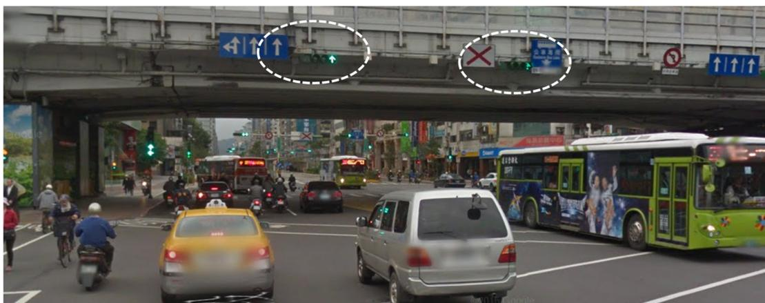
圖 2-14 高架橋增設遠端號誌（臺北市建國南路信義路）
