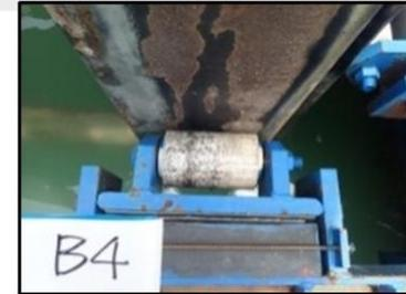
基樁與滾輪接觸處表面部分磨損·無撞擊凹痕
